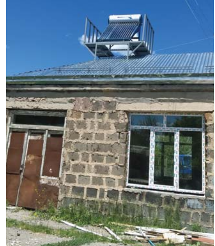
Արևային ջրասափացուցիչի տեղադրում Վանատուրի մանկապարտեզի սանիթին Solar water heater installation on the roof of Vanatur kindergarten
