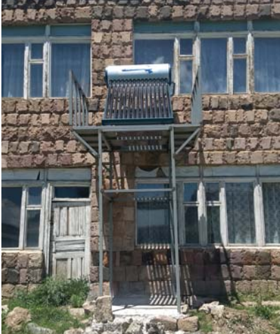
Արևային ջրասափացուցիչի տեղադրում Ջրառատի մանկապարտեզի սանիթին Installation of solar water heater on the roof of Jrarat kindergarten
